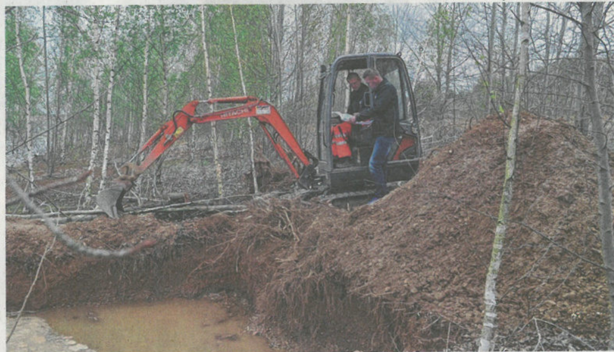
Michael Wichmann (rechts) und Baggerfahrer Heiko Giebler besprechen das weitere Vorgehen. Wird, wie in diesem Fall, ein Filterbrunnen im Planquadrat nicht gefunden, wird er mit einem Geogitter abgesichert. Foto: Ulrike Witt
